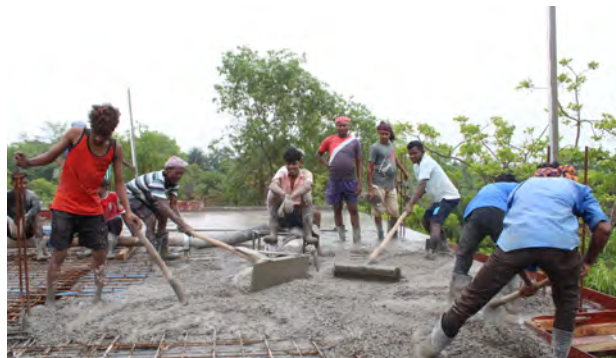
Bauarbeiten am „Center for Excellence“
