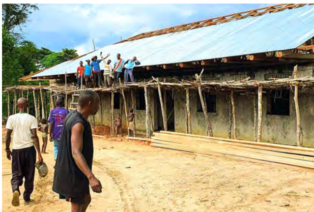
Eltern beim Dachdecken der Schule in Mondombe, die bereits teils renoviert ist.
