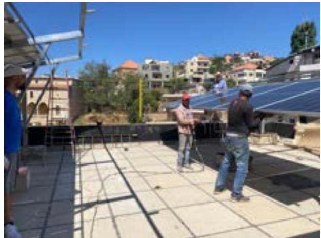
Installation einer Photovoltaik-Anlage in St. Josef/Libanon
