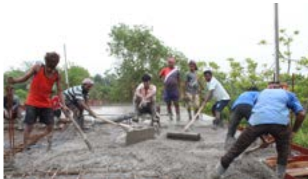
Bauarbeiten am „Center for Excellence“
