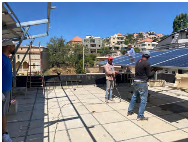
Installation einer Photovoltaik-Anlage in St. Josef/Libanon
